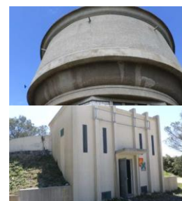
Figure 46 : Photos des réservoirs sur la commune (Source : SDAEP communal, 2017)
