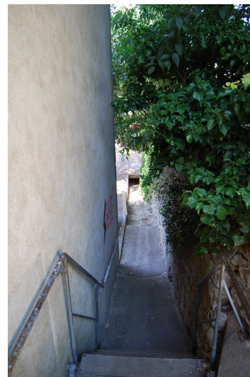
Réseau pluvial busé - Saint-Pargoire Source : Urban Projects
