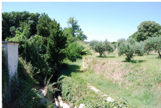
Réseau pluvial préexistant - Saint-Pargoire Source : Urban Projects
